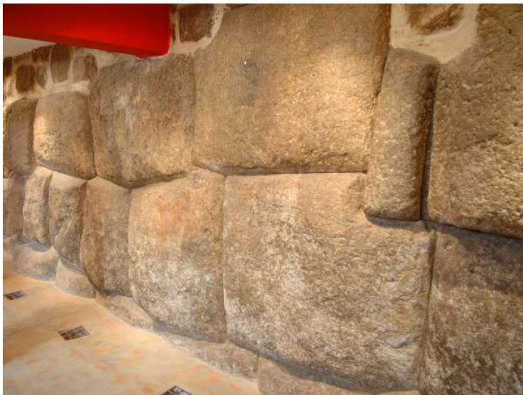
Figura 48: Los muros ciclópeos del tramo inferior de la calle Suecia
