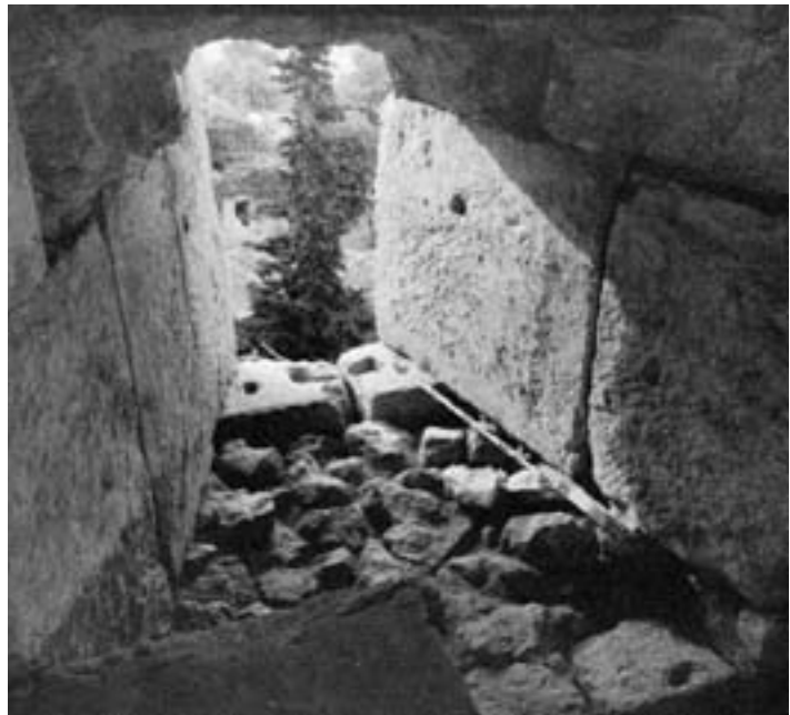
Fig. 25: Detalle de la aspillera de la Torre de Minerva en uno de cuyos sillares se descubrió en posición invertida el grafito dedicado a la diosa.
