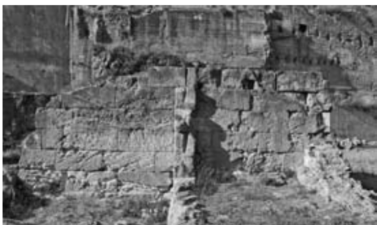
Fig. 46: Vista de detalle del paramento interior de sillares de la posible muralla de casamatas obliterada por la construcción del teatro romano.
