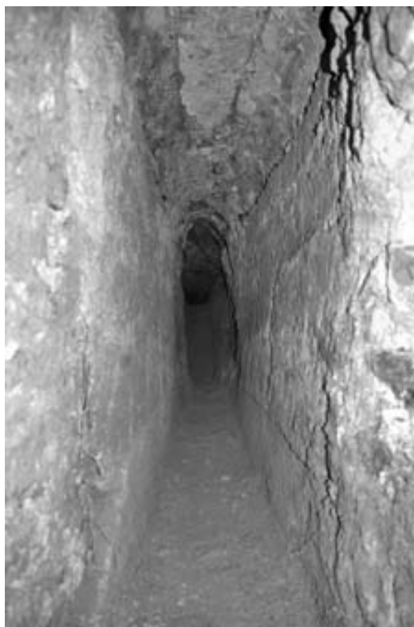
Fig. 118: Galería excavada por M. García y J.M. Macías en el subsuelo de la ciudad romana ( cuniculus ), al sur del área forense para aprovechamiento hidráulico de la red freática y conducción de las aguas hasta el ninfeo del teatro (PAT 2007, ficha 469). Foto J.M. Macías.
