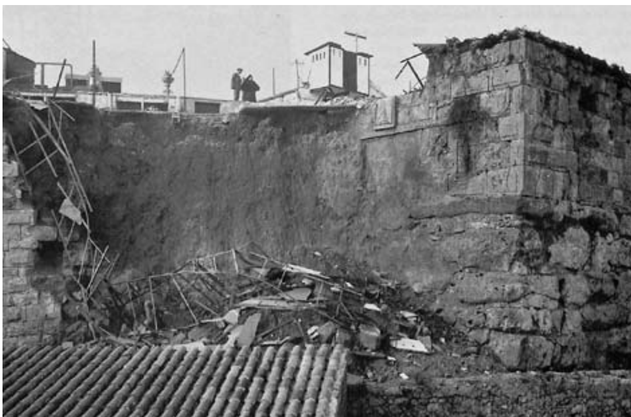
Fig. 15: Derrumbe del extremo del lienzo adosado a la torre de S.Magí ocurrido el 19 de febrero de 1932. Este derrumbe producido por filtraciones desde un convento adosado a la muralla, dejó al descubierto el relieve de la Minerva que decoraba la torre. Las tierras que se aprecian en el interior del lienzo derrumbado corresponden al relleno interior de adobes (Foto Real Academia de la Historia)
