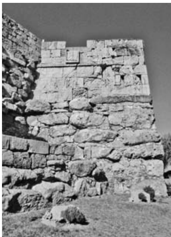
Fig. 17: Vista actual de la Torre de Minerva que muestra el relieve de la diosa aparecido con el derrumbe de 1932 que demostró indiscutiblemente la existencia de dos fases diferentes en la muralla. (Foto Àngel Rifà).
