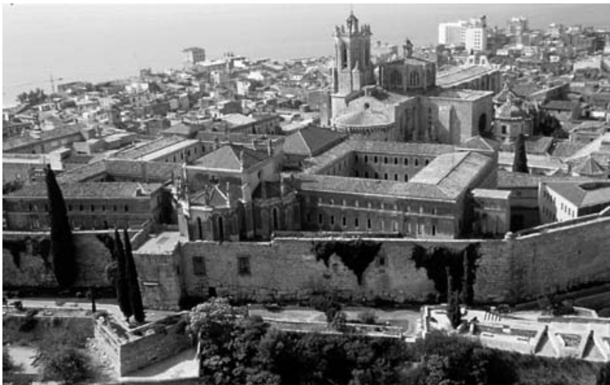
Fig. 38: Vista aérea de la Parte Alta de Tarragona. En primer término podemos ver la Torre del Cabiscol perteneciente a las defensas del primer campamento romano y los altos lienzos de sillares que corresponden a su ampliación en la segunda mitad del s.II a.C. Delante línea de baluartes (Falsa Braga) levantada en 1709 durante la Guerra de Sucesión.
