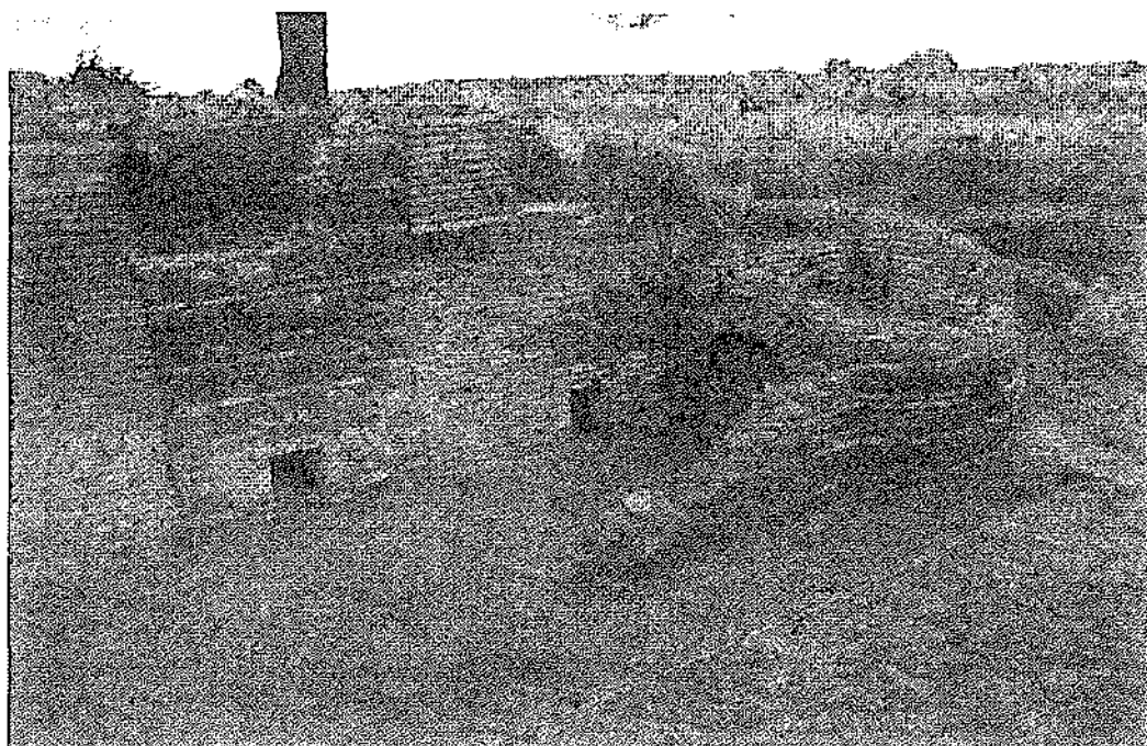
Lám. XXVIII.- Técnicas constructivas. Balneum instalado en los horrea en época severiana con paramentos de opus vittatum mixtum , fácilmente reconocibles de la obra inicial, latericia y reticulada.
