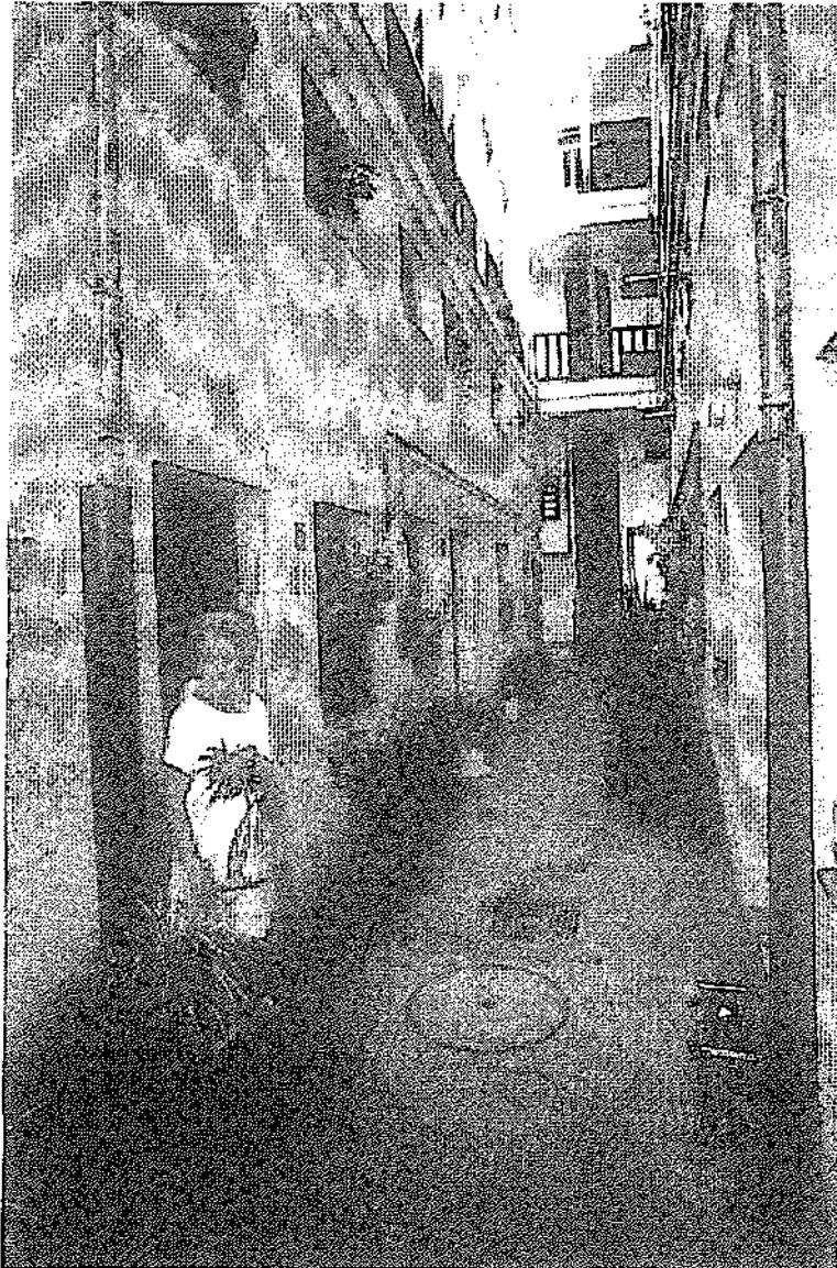
17.- Corrala de la calle Tribulete 11 con Provisiones n o 12, después de su rehabilitación y realojo de las familias. (Foto. Empresa Municipal de la Vivienda).
