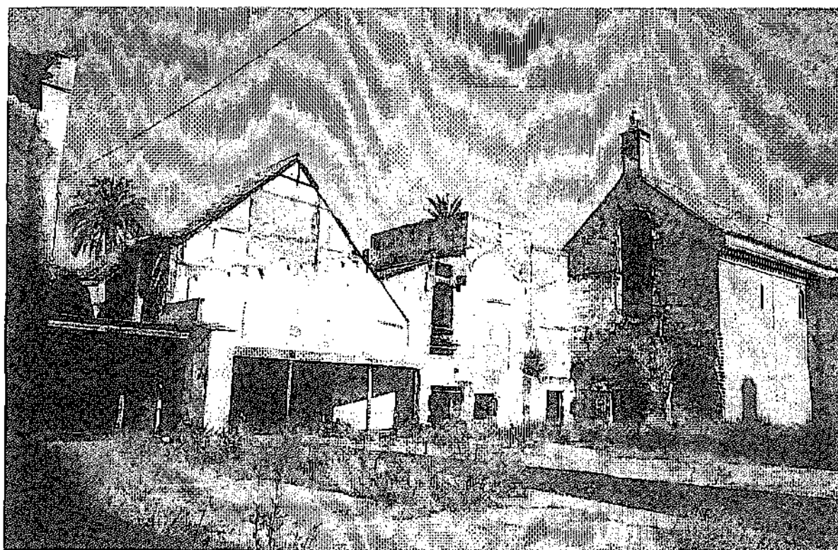
Extremo del Refectorio y acceso a Cocinas
