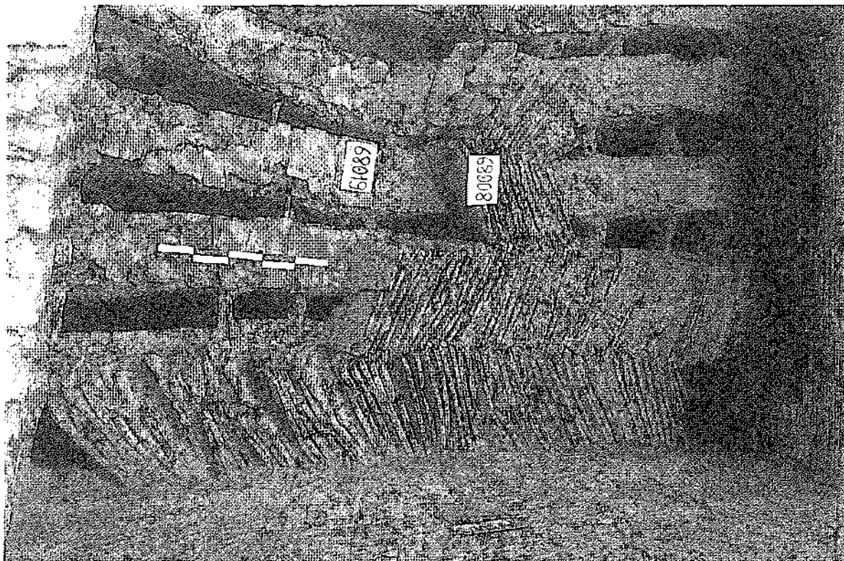
Figure 6 : Four de tuilier avec restes de la dernière cuisson en place
