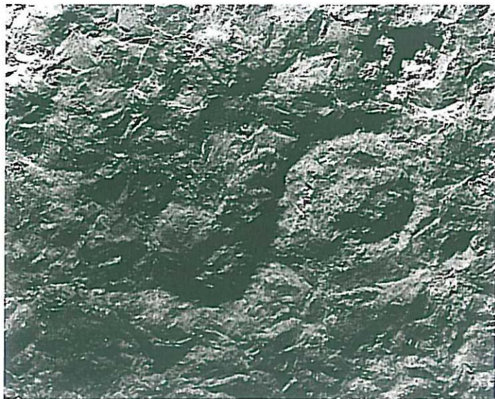
Fig.3.- Tarragona, Palacio Arzobispal. Muro de sillares, signo en forma de S.
