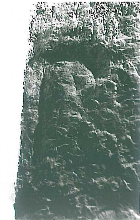
Fig.4.- Tarragona, Palacio Arzobispal. Muro de sillares, signo en forma de P.
