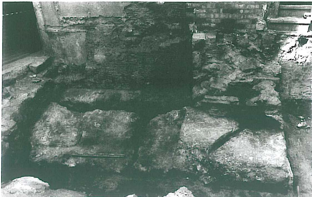
Fig. 7—Doble mur que configura l'estructura del podium del porticat de la Plaça de Representació: primera i segona filada de carreus; i massís d' opus caementicium . Sector I.
