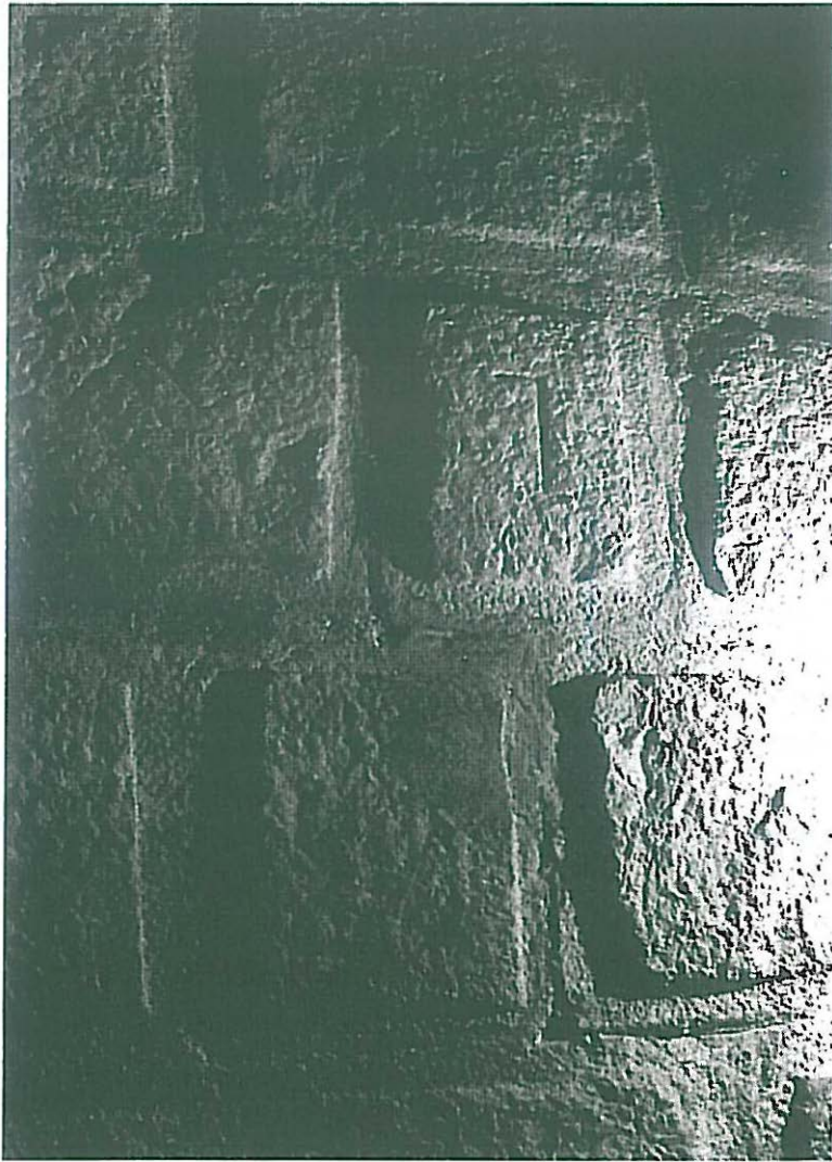
Fig.6.- Tarragona, Palacio Arzobispal. Muro de sillares, signos en la parte alta del muro.
