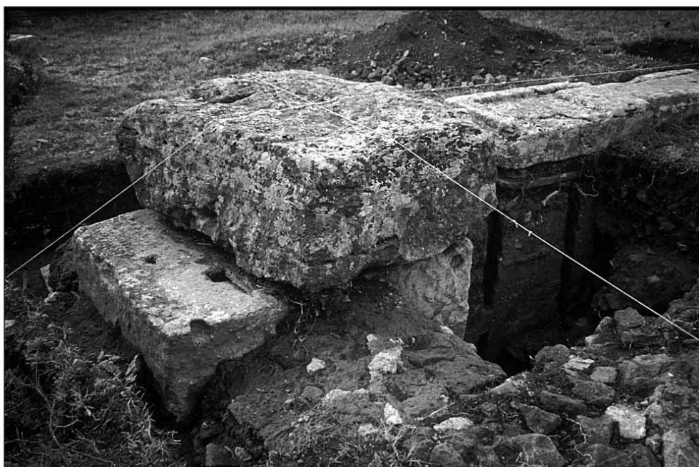
Fig. 25: Vista del macizo de cimentación formado por bloques de travertino aparecido en el sector 4 (Foto: D. Vivó).
