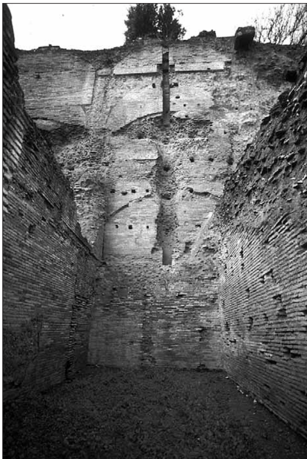
Fig. 17: Vista de la taberna n. 3 con el bajante de aguas pluviales alojado en el muro adrianeo (Foto: D. Vivó).
